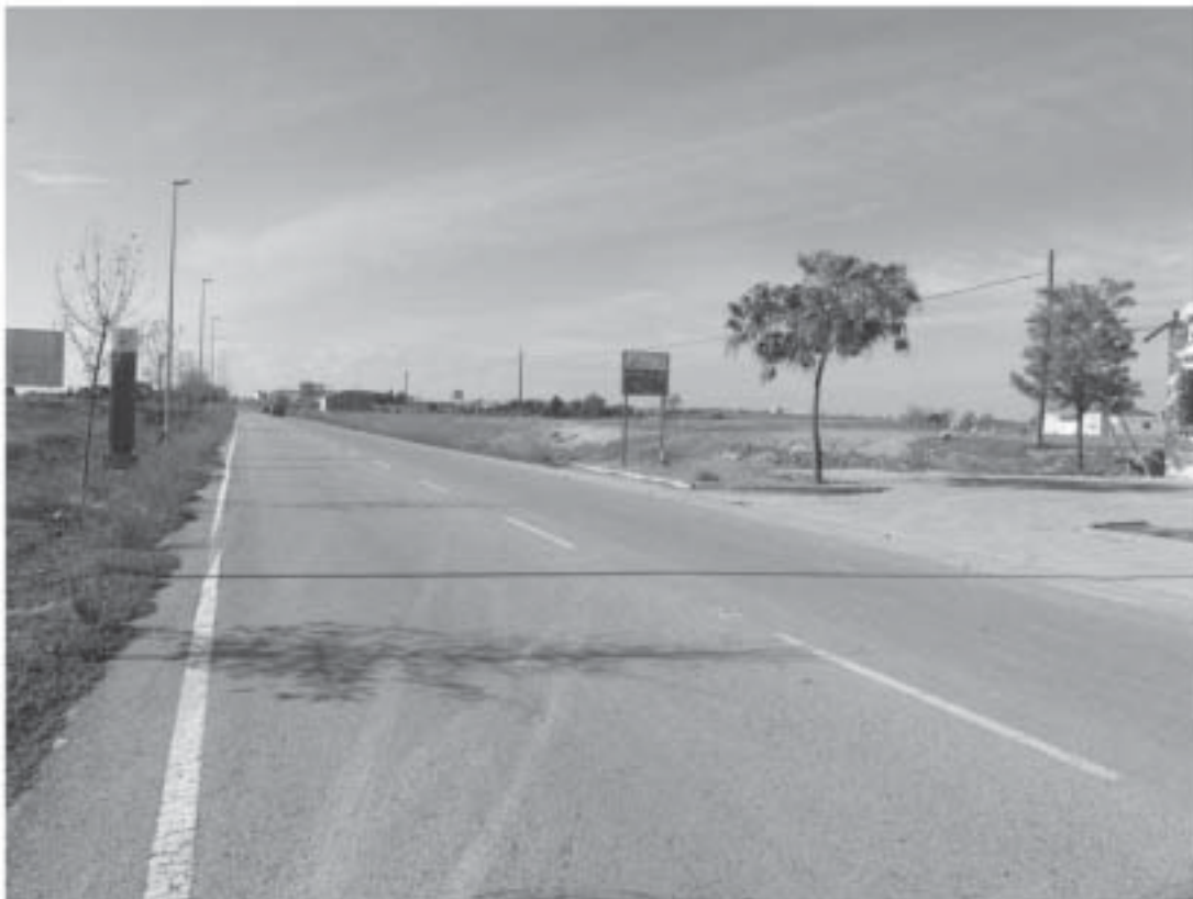
Vista del ámbito desde la Avenida de la Ossa de Montiel. Fecha fotografía: 20 de octubre de 2005.
